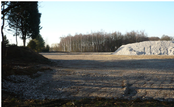
Das Baugrundstück vor der Erschließung
